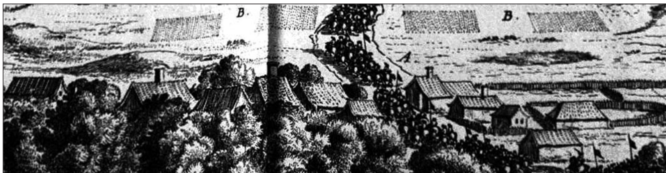
Ryc. 21. Budynki wsi umieszczone na sztychu przedstawiającym przebieg bitwy pod Filipowem.
