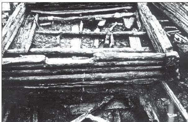
Ryc. 4. Wejście do domu wysoko usytuowane.
