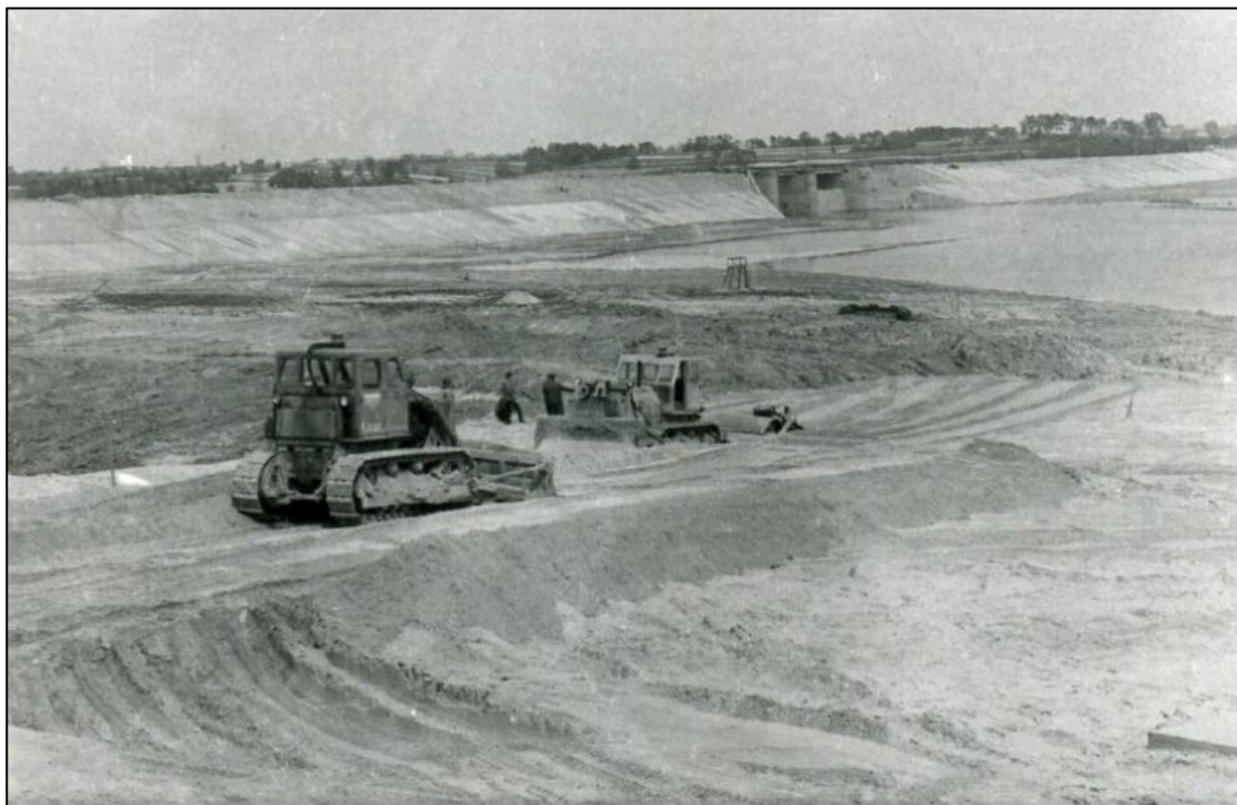
Fot. 4. Prace ziemne przy kształtowaniu dna zbiornika w okolicach dzisiejszego portu Maruś (fot. archiwum A. Kobalczyka)
